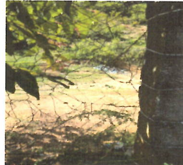
Foto 2: CERCO O MURO PERIMETRAL Sustitución malla de acero galvanizado en perímetro del establecimiento, con instalación fija y tensa, anclajes metálicos en intervalos regulares
