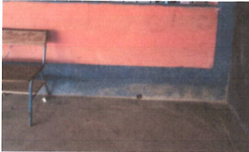
Foto 1: REPARACIÓN DE REPELLO Y CERNIDO DE PAREDES Reparación de repello y cernido en muro de mampostería con aplicación de acabado uniforme. Baños y dirección.
