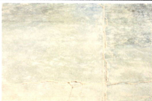
Foto 3: PISO Sustitución de piso de concreto con acabado liso por piso cerámico, incluyendo preparación de superficie y nivelación. Direccion
