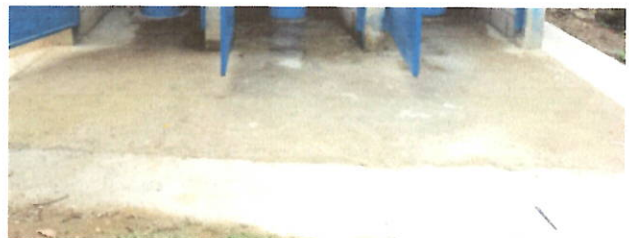
Foto 4: PISO Sustitución de piso de concreto con acabado liso por piso cerámico antideslizante, incluyendo preparación de superficie y nivelación. Baños
