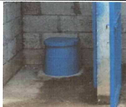
Foto 6: SERVICIOS SANITARIOS Y SUS ACCESORIOS Sustitución de sanitarios ciegos, por sanitarios lavables, accesorios y conexiones.
