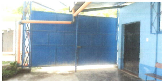
Foto 1: MANTENIMIENTO A PORTONES mantenimiento a portón de ingreso, material: metálico, incluye: bisagras y sistemas de cierre, retiro de oxido y aplicación de pintura.
