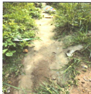
Foto 2: CUNETETA DE CONCRETO Reparación de canales de concreto para conducción superficial de agua pluvial, con pendiente y refuerzo. Atrás de aula 1,2 y a la par de aula 1 y baños
