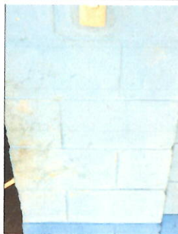
Foto 3: PINTURA EN MUROS INTERIORES Y EXTERIOR Preparación de la superficie y aplicación de pintura a dos manos, en paredes interiores y exteriores del establecimiento y dirección
